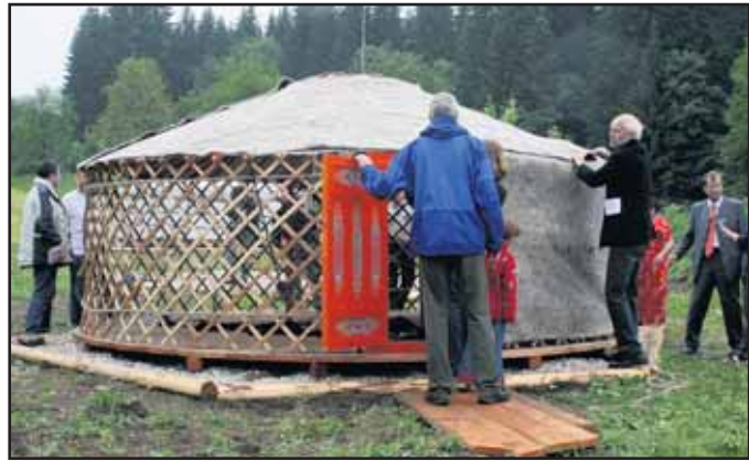
Das Grundgerüst der Jurte ist ein einfaches Scherengitter, welches mit Filz und mehreren Lagen verschiedener Stoffe in Windeseile in eine behagliche Unterkunft verwandelt wird.
