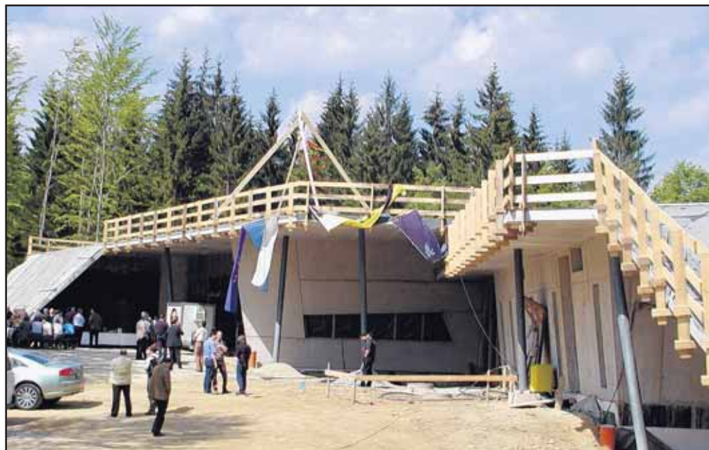
Zweieinhalb Jahre nach dem Spatenstich wurde am 21.05.2004 bei schönstem Sommerwetter Richtfest gefeiert.
