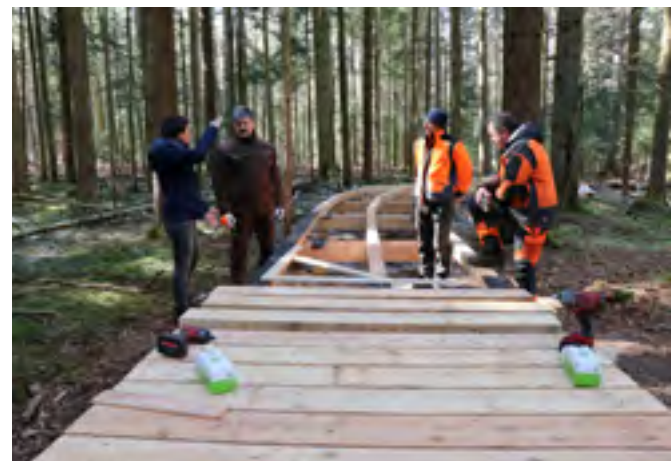
Der Steg, auf dem Besucher einen sich verjüngenden Wald bestaunen können, wurde abgebaut und komplett erneuert. Von den Bauarbeiten machte sich Nationalparkleiterin Ursula Schuster ein Bild. Foto: Annette Nigl
