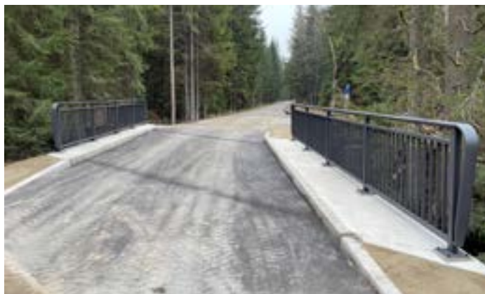
Mitte November waren die Arbeiten an der Schwarzachstraße abgeschlossen. Fotos: Johannes Dick
