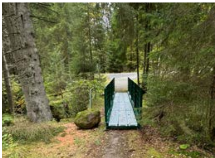
Dank einer Behelfsbrücke kann der Radweg von der Schwarzachstraße Richtung Racheldiensthütte weiter befahren werden. Die darunter liegende Brücke muss saniert werden.
