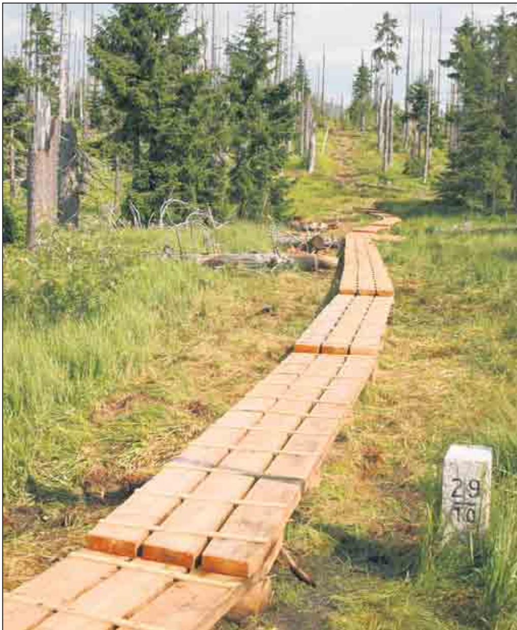
Über das Stangenfilz an den Blauen Säulen wurde ein naturschonender Holzbohlensteg verlegt.
