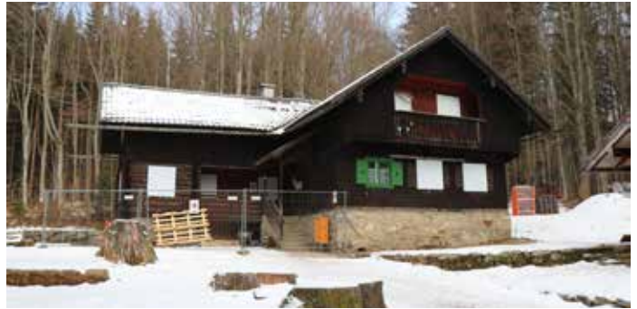
Nur im Winter war es ruhig auf der Baustelle an der Racheldiensthütte, die Monate zuvor wurde kräftig renoviert. - Foto: Gregor Wolf
