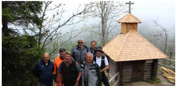
Das Dach der Rachelkapelle erstrahlt nach der Sanierung durch den Bayerischen Wald-Verein wieder in neuem Glanz. - Foto: Elke Ohland
