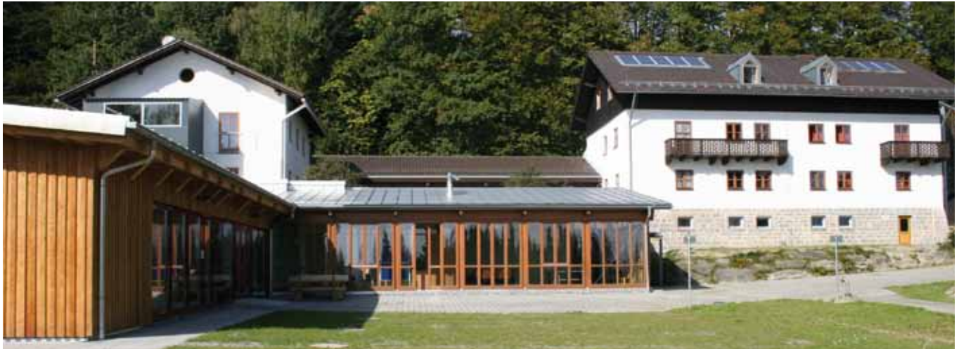
Gesamtansicht des Jugendwaldheims mit Holz-Neubau im Vordergrund (Foto: R. Pöhlmann).
