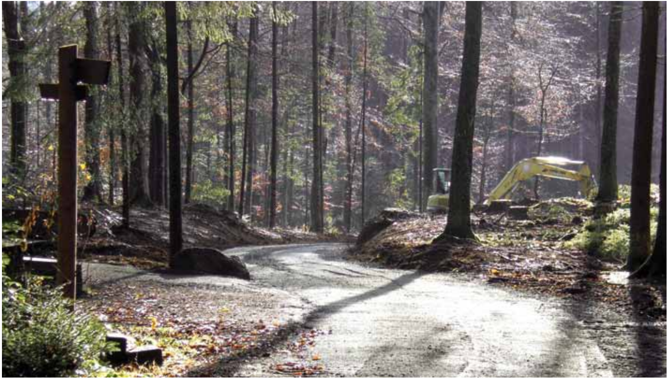
Nach dem Ausbau der Wege darf sich das Tier-Freigelände im Nationalparkzentrum Lusen als barrierearm bezeichnen (Foto: M. Hußlein).
