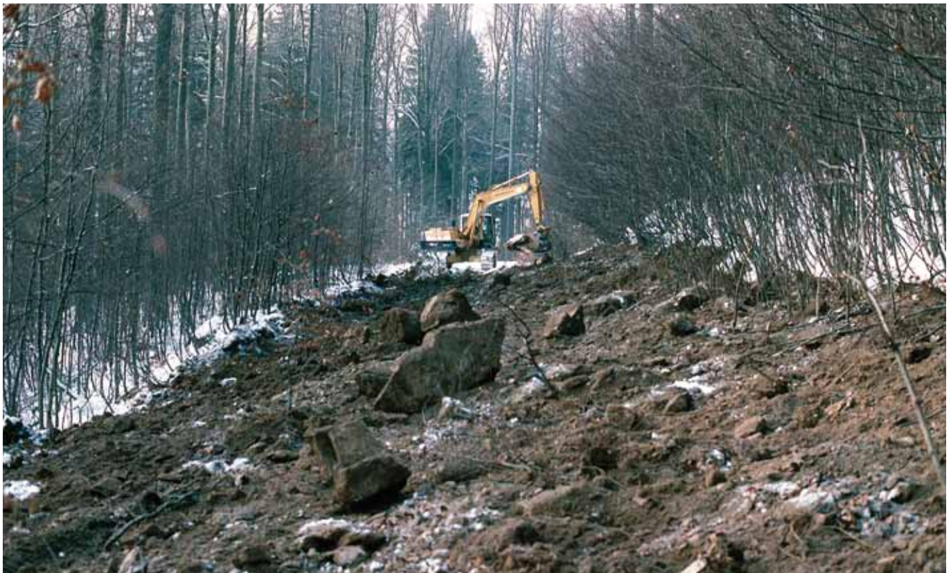
Beim Rückbau ehemaliger Holzabfuhrstraßen wird neben der Beseitigung des Straßenkörpers auch das ursprüngliche Geländereief wieder hergestellt (Foto: H. Strunz).
