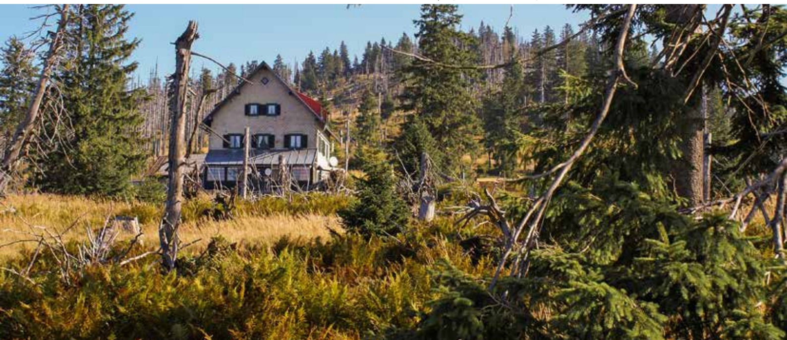
Das Waldschmidthaus befindet sich nun im Besitz des Nationalparks. Dort stehen umfangreiche Renovierungsarbeiten noch an. Foto: Dr. Franz Leibl
