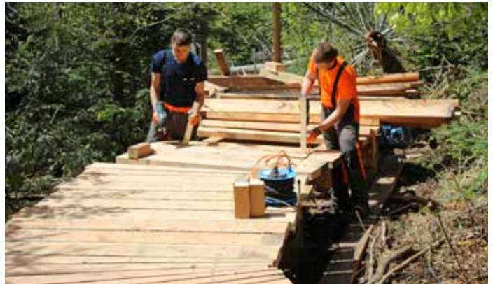
Die Auszubildenden Maximilian Faschingbauer und Johannes List beim Bau der mittlerweile fertiggestellten Plattform nebst Bohlensteg nahe des Biber-teichs. Foto: Elke Ohland
